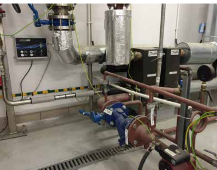
zabezpieczenie płytowych wymienników ciepła Danfoss
