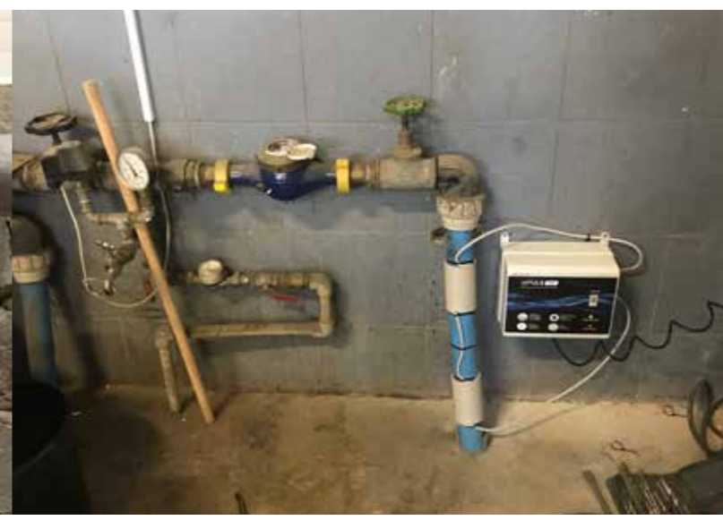
zabezpieczenie instalacji wody zasilającej zakład
