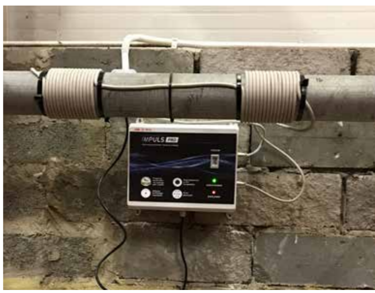
zabezpieczenie instalacji wody zasilającej zakład
