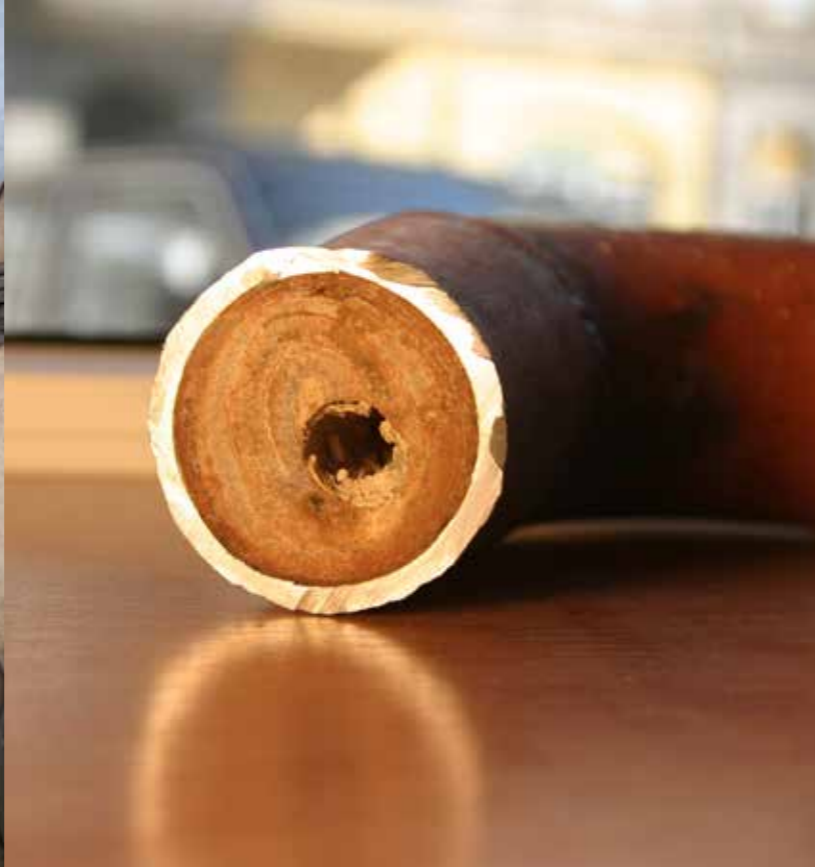
Rura stalowa, w której odkładający się kamień całkiem zatrzymał przepływ wody
