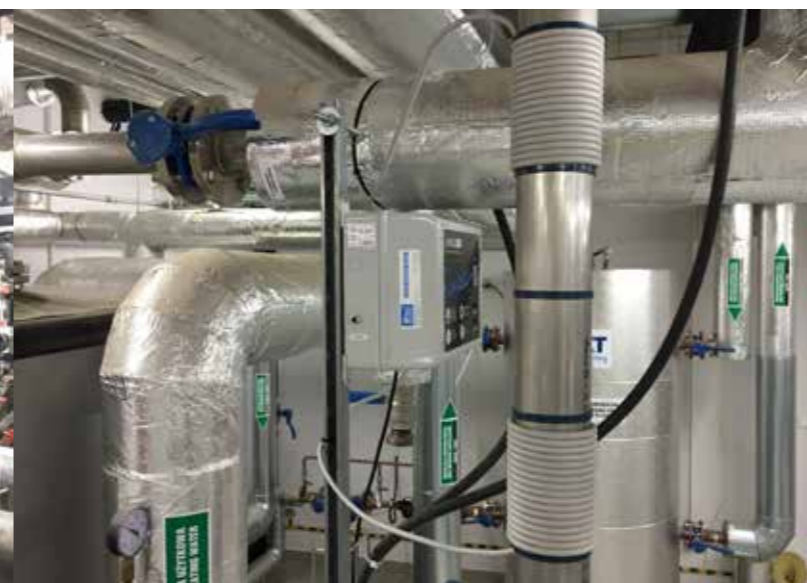
zabezpieczenie instalacji wody zasilającej zakład
