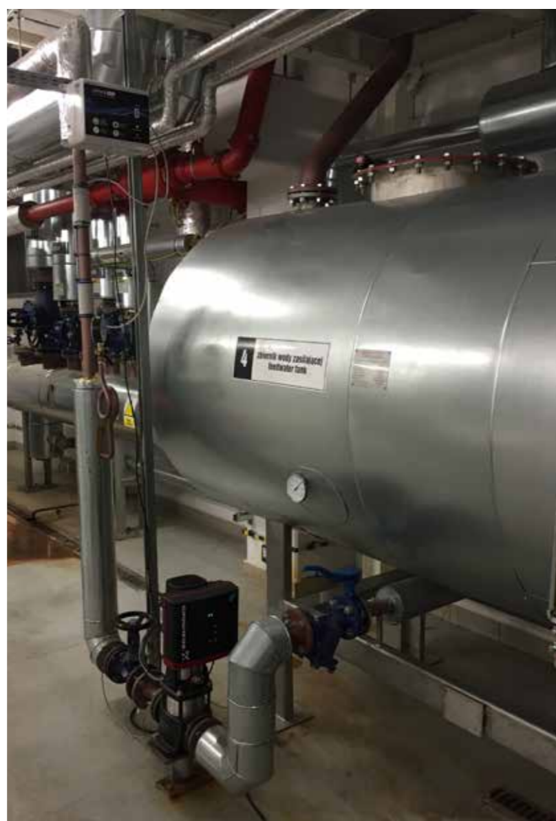
zabezpieczenie instalacji wody zasilającej kocioł
